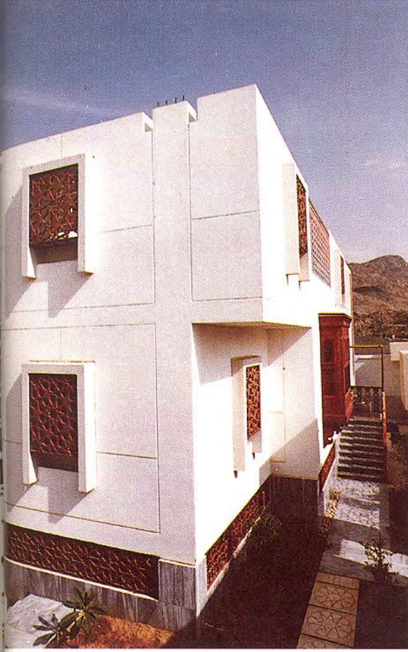
١٣ - خط السماء ديناميكي يوحي بأن المبنى قابل للامتداد الرأسي وتم تأكيد العناصر الانشائية بواسطة الغراميس التي ترسم الهيكل الانشائي وبواسطة التجويف العلوي حول الأعمدة. ونرى في وسط الصورة تفصيلة النافذة الصغيرة المقبسية المتكررة.
